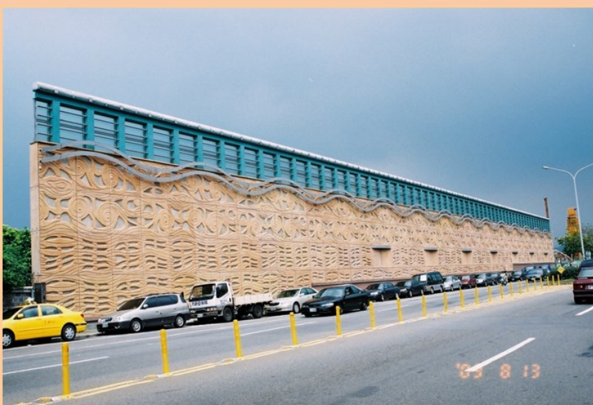
松山機場吸音圓筒隔音牆
